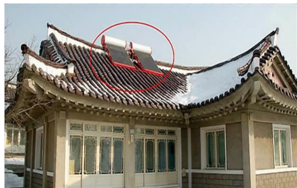
도표 97 태양열 온수공급장치도 보급 중
